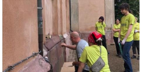
geben. In Verbindung mit der Deutschen Stiftung Denkmalschutz werden 15-20 junge Erwachsene aus ganz Deutschland an der Bennunger Kirche lernen und arbeiten. Am brüchigen Putz der Südseite werden erste Sanierungsarbeiten unter Anleitung von Handwerksmeistern durchgeführt, und auch das Fundament aus Sandstein und die Holzfenster werden bearbeitet.
